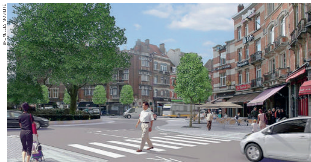
Le nouveau visage du rond-point du cimetière d'Ixelles. Clôture des travaux prévue à la fin août.
